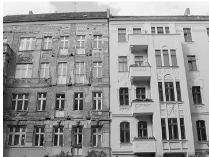
Abb. 1 und 2: Renovierte Wohnhäuser in Prenzlauer Berg. (Fotos: Hartmut Häußermann)
